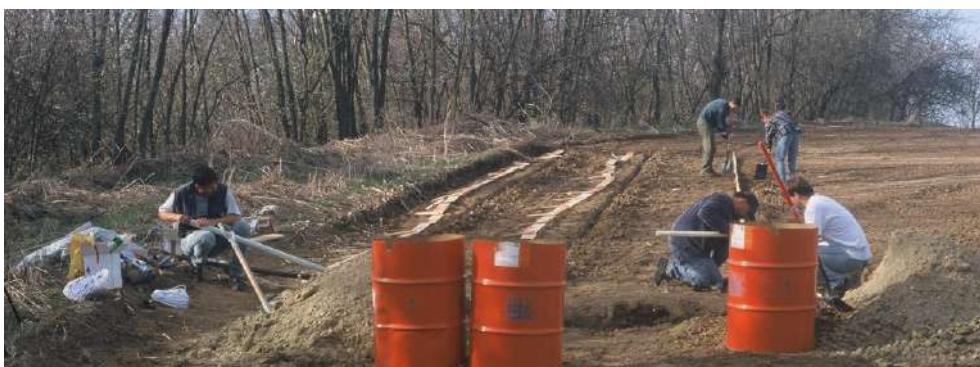
7. ábra A somogybabodi USLE (Universal Soil Loss Equation) eróziós parcella építése 1999-ben (Fotó: Centeri Cs.), Barczi Attila a háttérben zöld felsőben
