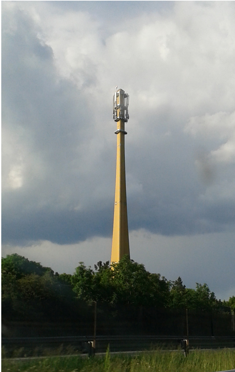
15. ábra Modern telekommunikációs torony Figure 15. Modern telecommunications tower
