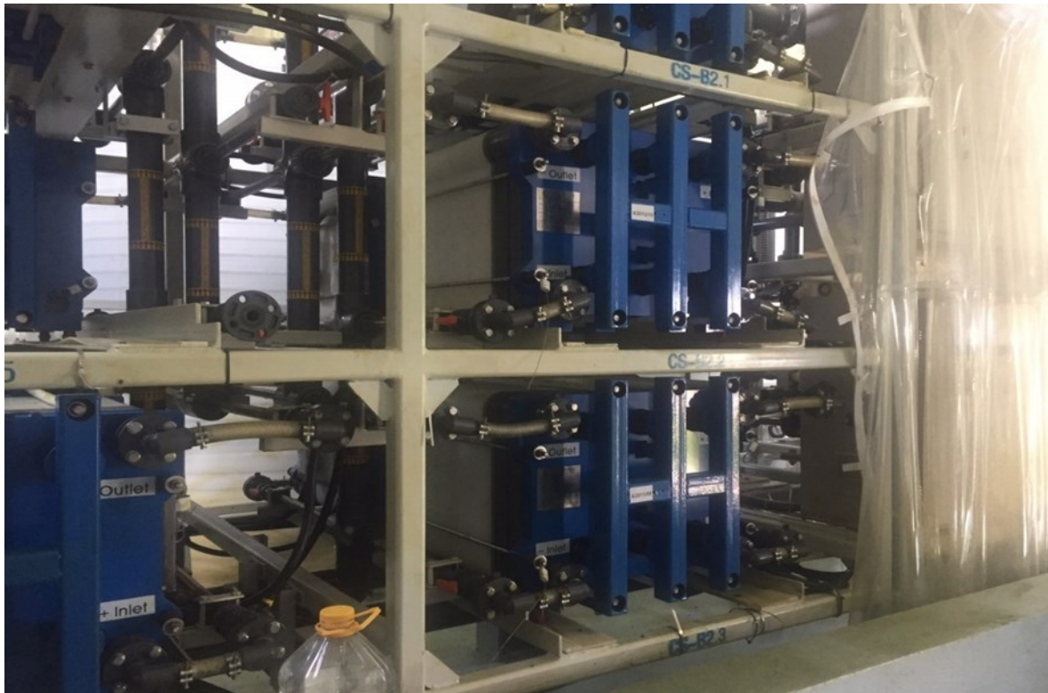
4. ábra: Vanádium akkumulátor rendszer
