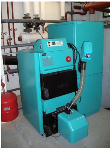
2. ábra. A pelletkazán a pellet égőfejjel, előtároló tartállyal és csigás adagolóval, ill. a füstgáz elemző műszer (saját fotó, ill. Internet3)
