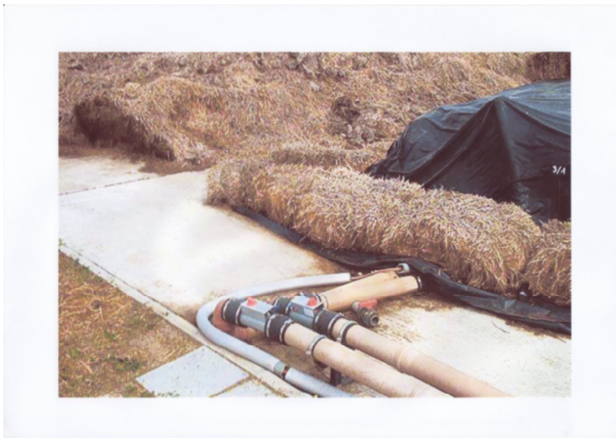
4. kép: Levegőztető csőrendszer (ATEVSZOLG Zrt., Solt)
