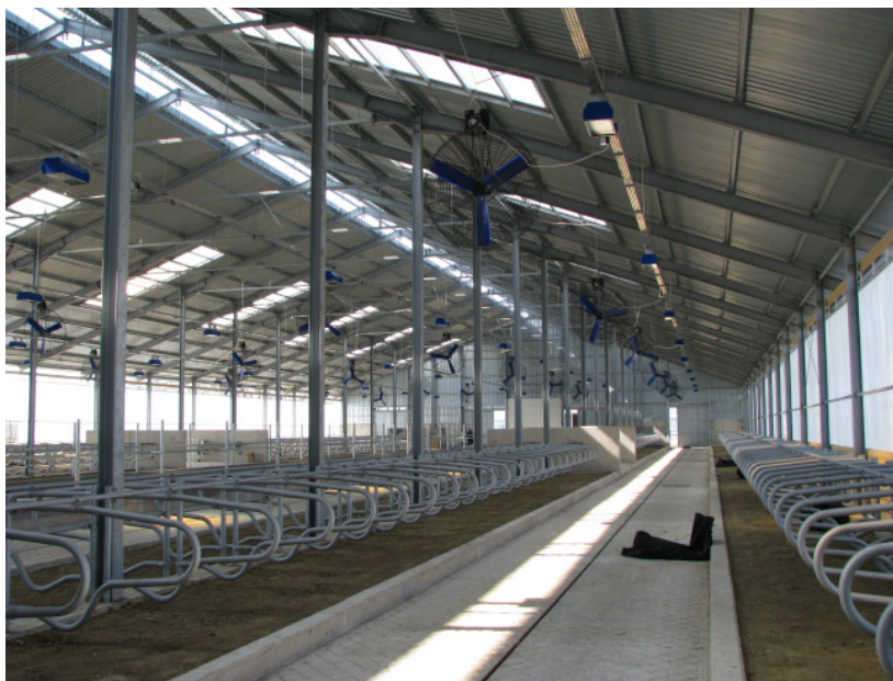
2. kép: Ventilátorok egy készülő istállóban
