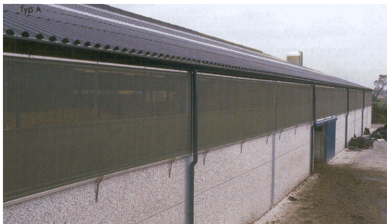
2. ábra: Változtatható oldalfalnyílású sertésistálló
