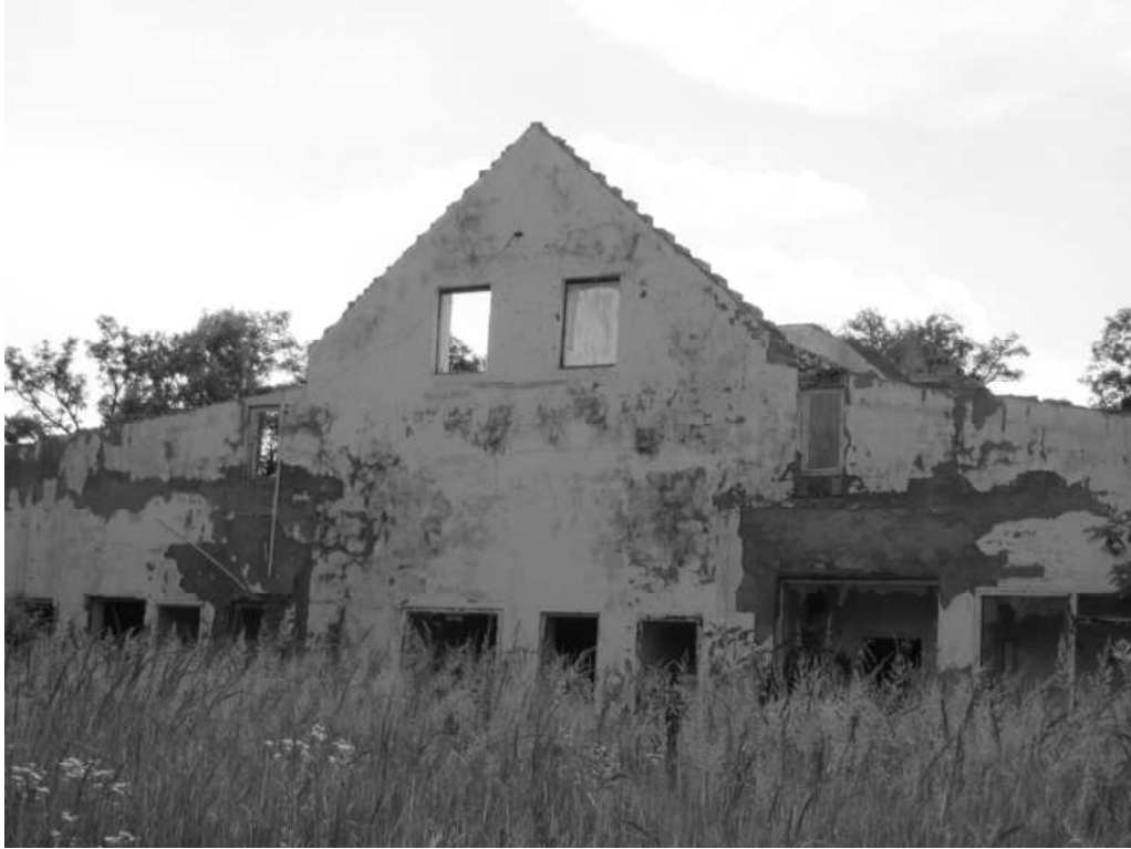
16. kép: Pusztuló bányüzem-épület
