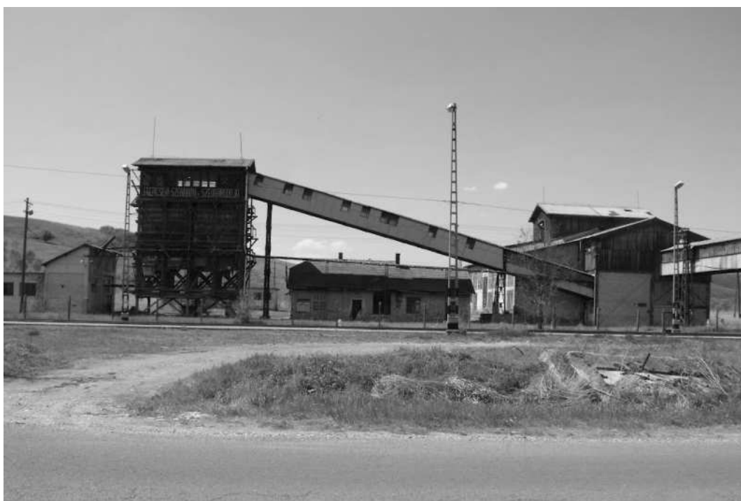
15. kép: Az Egercsehi Szénbánya egykori szénrakodó állomásának épületegyüttese Mónosbél vasútállomásánál (már teljes egészében lebontásra került). Forrás: panoramio.com
