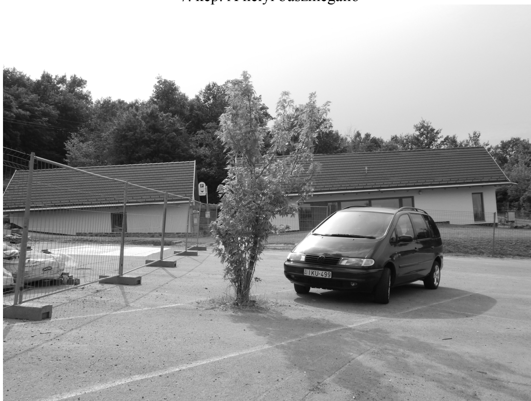
8. kép: Épülő parkoló a turisták számára
