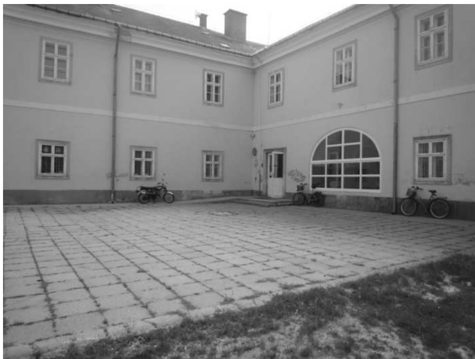
14. kép: Az iskola udvar felőli bejárata
